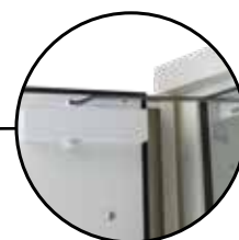
Ferme-porte avec thermofusible
