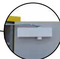
Ferme-porte avec thermofusible
