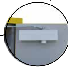
Ferme-porte avec thermofusible
