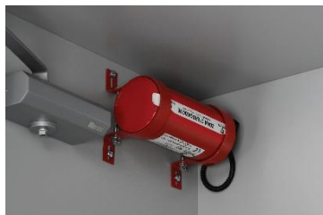
Extincteur spécial lithium-ion avec détecteur de température
