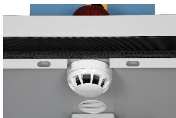
Centrale d'alarme sonore et visuelle, avec détecteur de fumée et extincteur spécial lithium-ion
