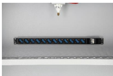
Racks de 10 prises électriques avec disjoncteur
