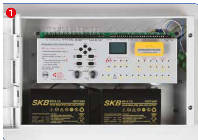
Centrale d'extinction automatique
